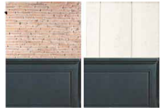
ENSEMBLE B Après dépose du revêtement exist. Pose de briquettes de parements
